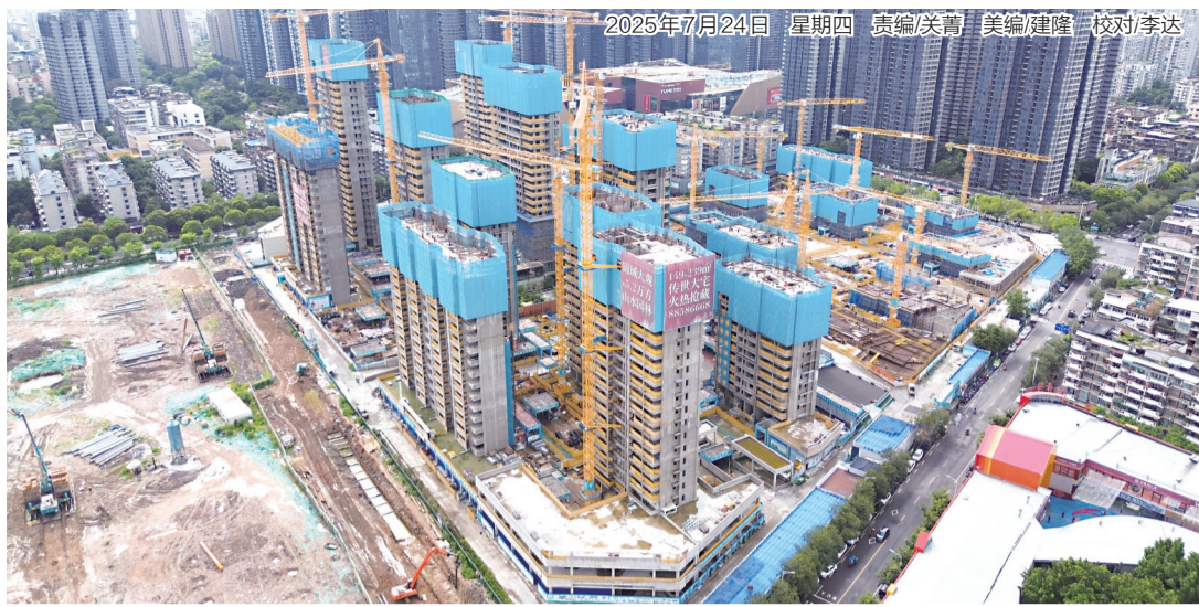
榕发锦熙公馆全面进入主体结构施工阶段
