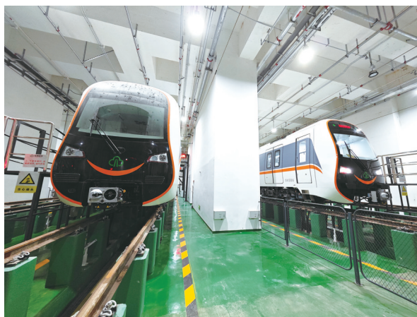
4号线后通段正式启动空载试运行(洪塘停车场)
