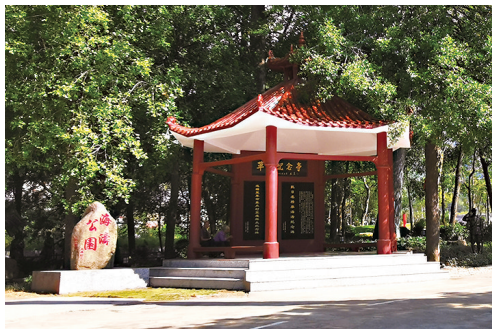
上杭县溪口乡大岭下村修建的革命纪念馆
