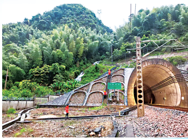
工作人员正在检查铁路沿线隧道山体情况(张磊/摄)
