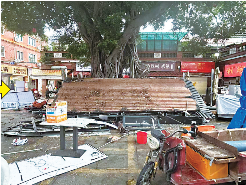
目前违建的铁皮房已被拆除
