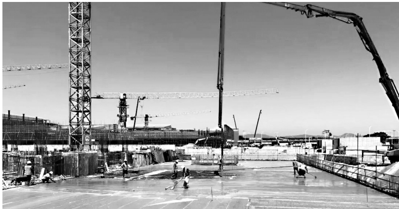
机场枢纽地下市政配套工程主体结构封顶(交建集团供图)
