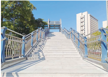
泉州五中城东校区人行天桥改造前和改造后
