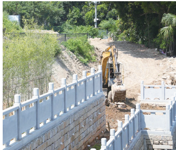
八卦沟两岸正在进行挡墙砌筑和景观绿化施工,将打造“水清、岸绿、河畅、景美”的古城生态新景观
