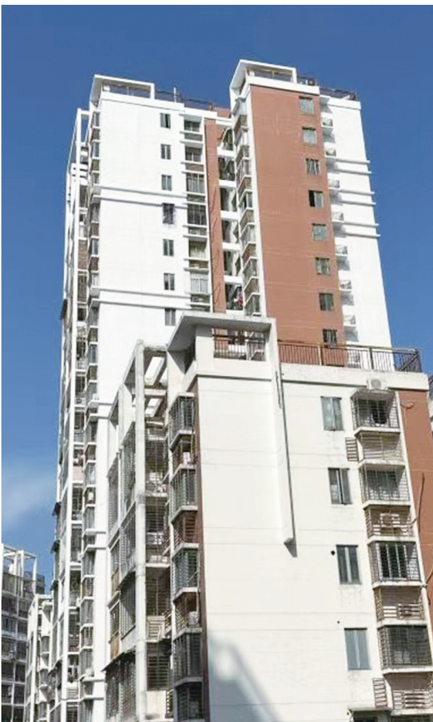
修缮后,外墙焕然一新
