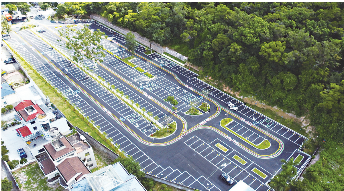
航拍停车场,标识清晰,还保留了原有的树木绿植 (海都记者 马俊杰/图)
