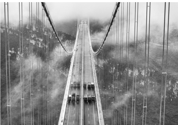
8月21日拍摄的贵州花江峡谷大桥荷载试验现场
