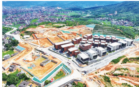
“五矿智慧工坊·中国(南安)高端阀门智造产业园”二期建设现场
