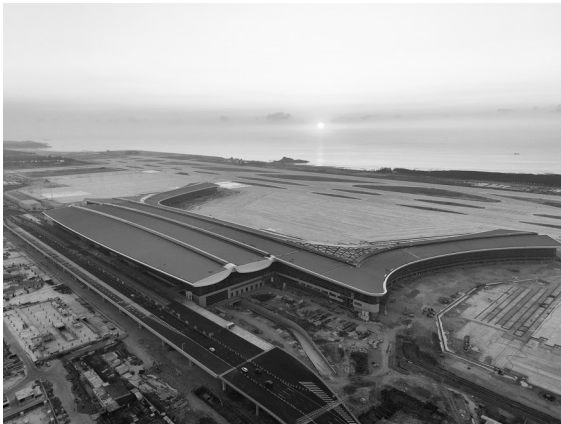
福州长乐国际机场二期扩建项目T2航站楼
