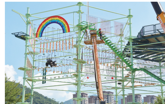
在建的高空游乐设施(部门供图)
