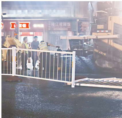
二十三日晚十一时许,路面正在施工
