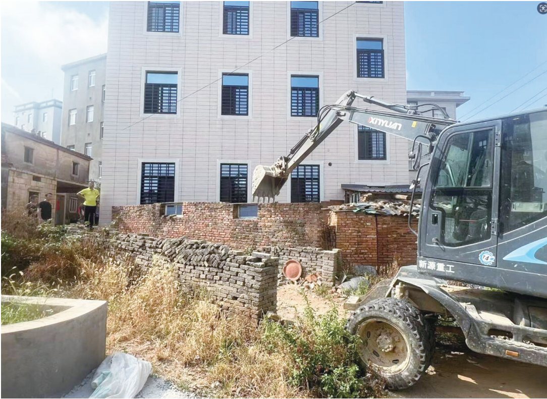
江镜镇林厝村拆除一处违建围墙
