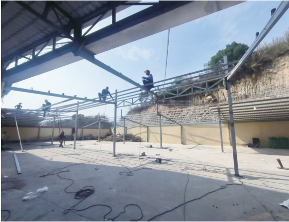
龙田镇拆除铁皮房
