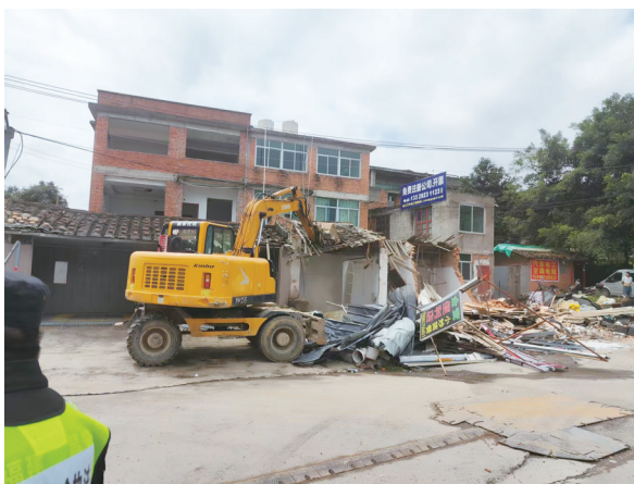
沿街违建房被拆除
