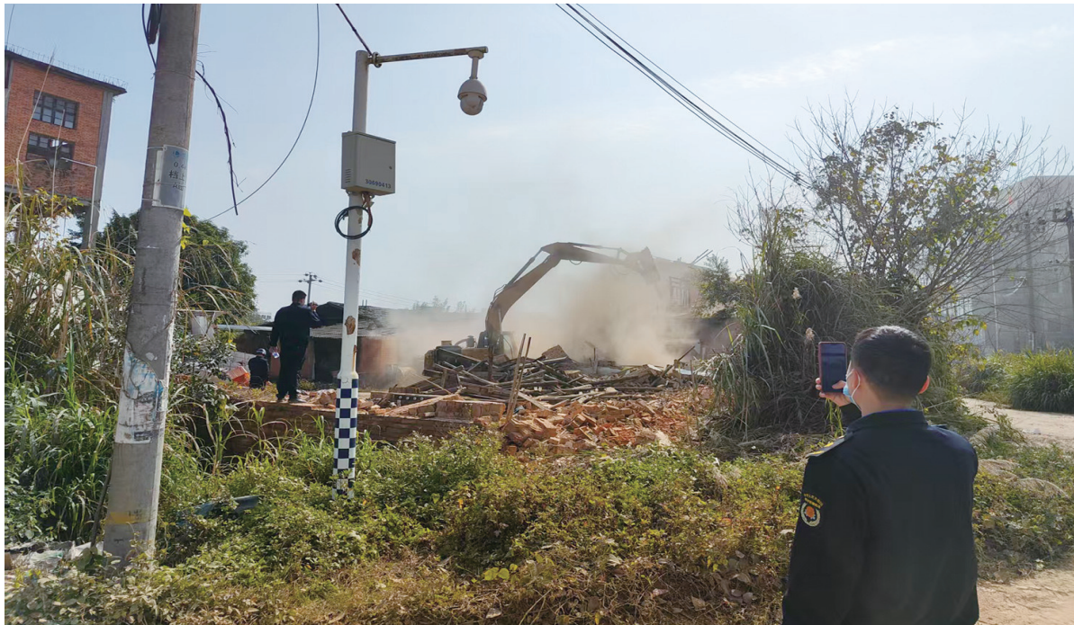
南屿镇新联村违建房屋被拆除
