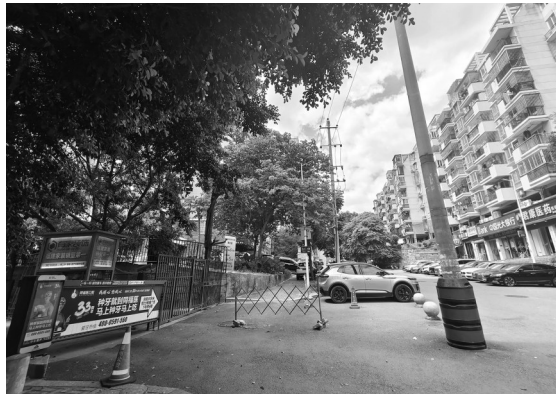
水泥杆位于小区门口,影响居民通行
