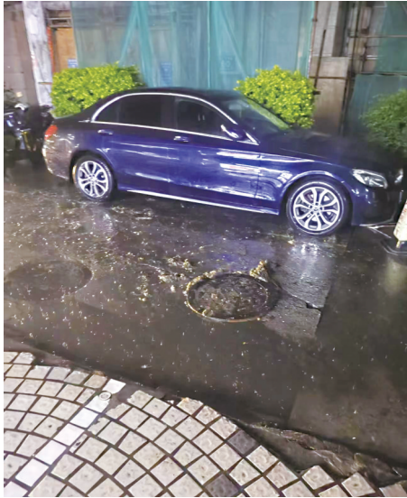
维修前,雨天污水外渗(受访者供图)
