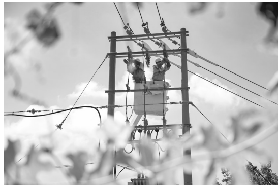
国网石狮市供电公司全力保障电网稳定运行
