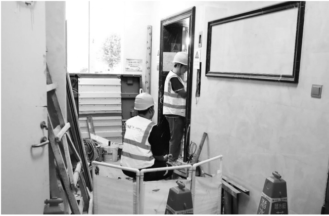
电梯安装现场
