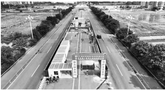
项目施工现场
