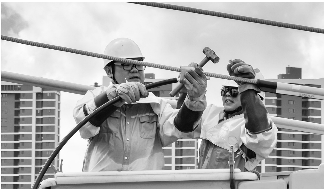
国网石狮市供电公司展开秋冬季安全大检查
